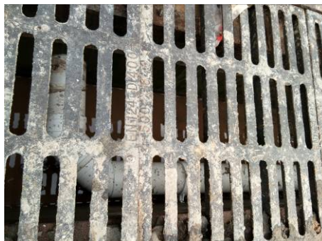
生产废水收集管（白色塑料管）
