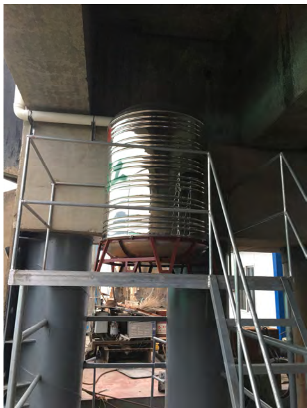
码头平面初期雨水收集装置（上端）
