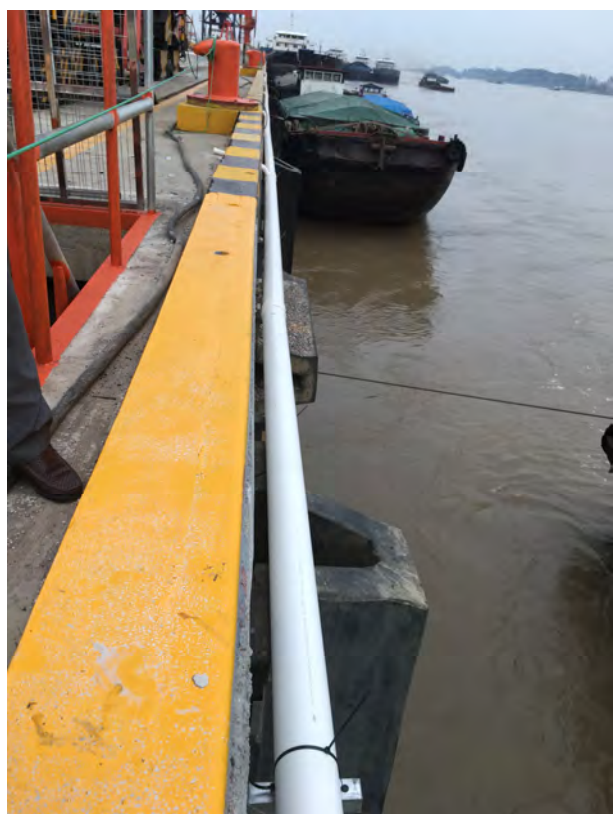
码头平面初期雨水收集管（码头平面）
