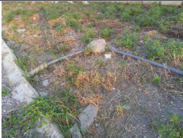
码头平面初期雨水收集管（引入堆场收集池）
