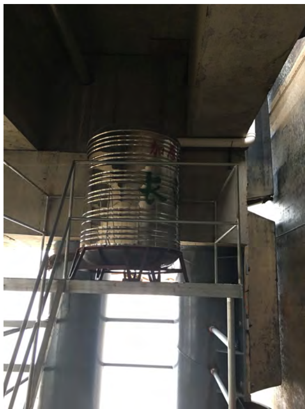
码头平面初期雨水收集装置（下端）
